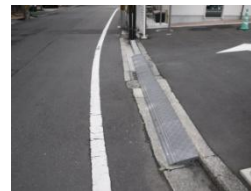
新橋支店 施工前
