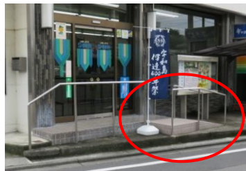
泉町支店 手すり
