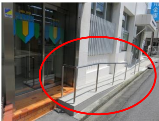
城南支店 手すり
